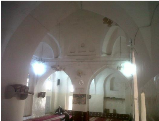
شكل (15-16) الدعام المعقودة تحمل قبة مسجد الأُسدية باب وتأثير ضوء النهار على الفضاء الداخلي للمسجد (طلاب العمارة - جامعة إب 2014)
