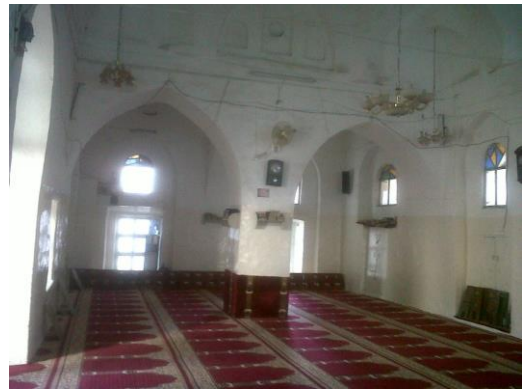
شكل (15-16) الدعام المعقودة تحمل قبة مسجد الأُسدية باب وتأثير ضوء النهار على الفضاء الداخلي للمسجد (طلاب العمارة - جامعة إب 2014)
